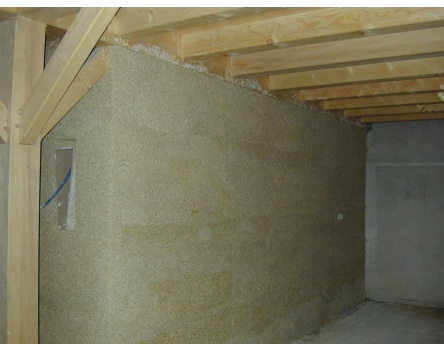
Mur en béton de chanvre et chaux
