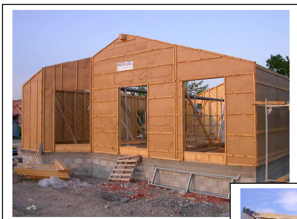
Début de construction
